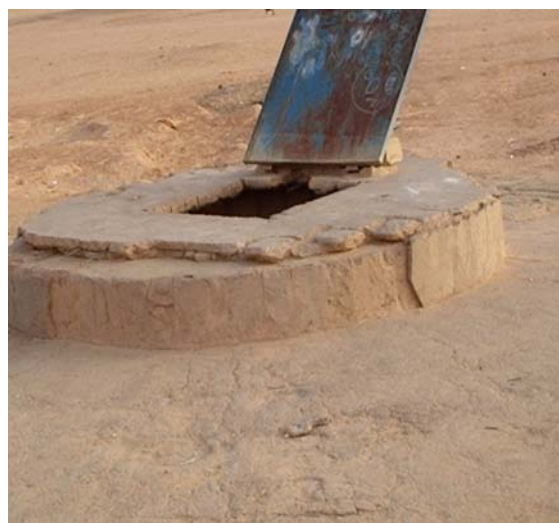
PUITS A GRAND DIAMETRE
